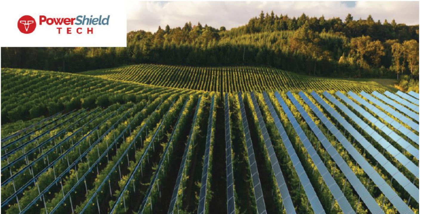
Le système ainsi configuré est capable de produit de **400 à 700 kW de puissance nominale par hectare**, grâce à l'installation optimisée de panneaux performants répartis sur la longueur des rangées de manière à ne pas produire d'ombrage excessif et à permettre une culture optimale des fruits.
