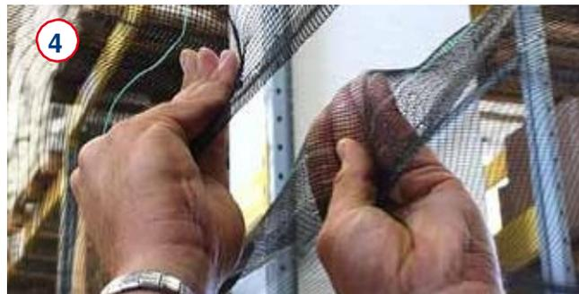
Encastrer dans le filet (photo 5) la partie mâle de la demi-plaquette femelle en appuyant sur le filet avec les doigts (photo 6), afin de bien y faire pénétrer les crans. Attention : le trou central doit être tourné vers le bas !
